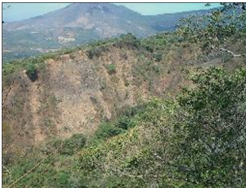
Foto 10-Ladera oeste. Inestabilidades 10 y 11
